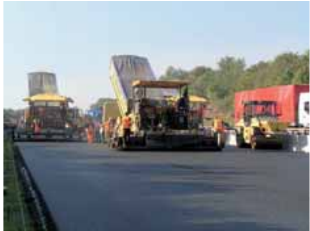
Straßenfertiger beim Einbau einer Asphaltdeckschicht
