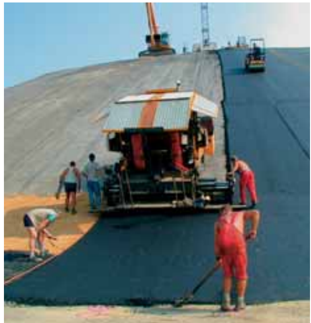
Einbau einer Asphalt-dichtung an der Deponieböschung
