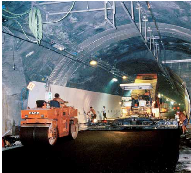
Einbau des Asphaltbelags im Mont-Blanc-Tunnel
