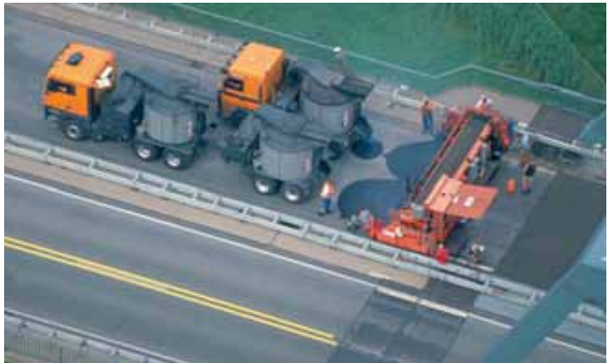
Einbau von Gussasphalt auf einer Stahlbrücke
