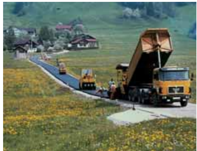
Asphaltierung einer Gemeindestraße
