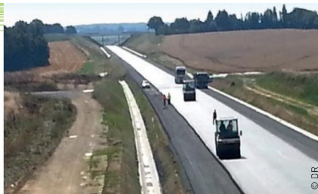
ferroviaire (de l'ordre de cent ans), nous avons souhaité un dosage en bitume un peu plus élevé que ne l'indiquait le calcul, poursuit M. Dos Santos. Grâce à notre retour d'expérience sur le réseau AP2R, nous savions que la durée de vie optimale est obtenue avec 4,8 % de bitume et une compacité de 96-97 % (de 3 à 4 % de vides), que nous avons atteinte en 8 passes (jusqu'à 10) des compacteurs. »
