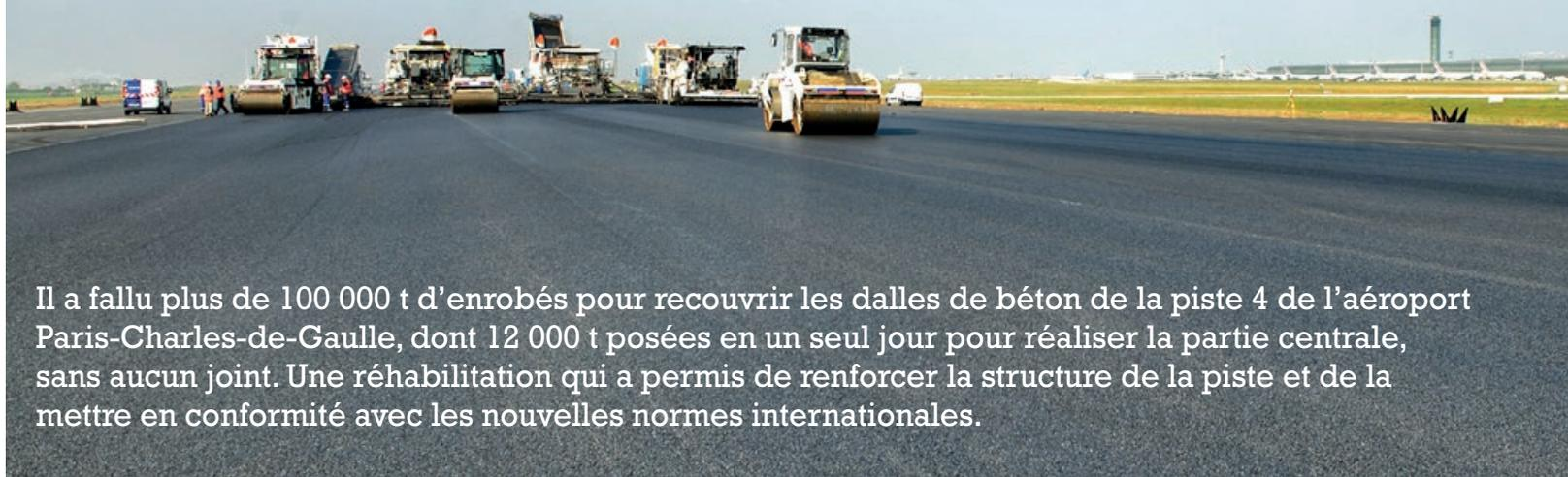
Il a fallu plus de 100 000 t d'enrobés pour recouvrir les dalles de béton de la piste 4 de l'aéroport Paris-Charles-de-Gaulle, dont 12 000 t posées en un seul jour pour réaliser la partie centrale, sans aucun joint. Une réhabilitation qui a permis de renforcer la structure de la piste et de la mettre en conformité avec les nouvelles normes internationales.
