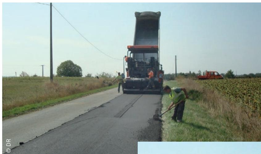
Pose et compactage d'une couche unique de béton bitumineux à l'émulsion.
