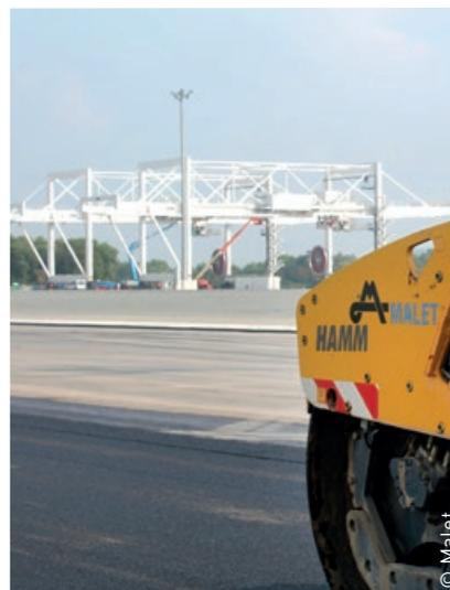
Le compactage à haute énergie a permis d'obtenir des teneurs en vides inférieures à 3 %.
